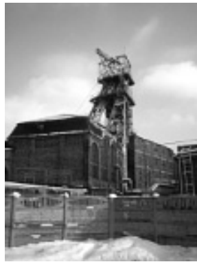
Jeden z szybów kopalni „Wieczorek” (dawniej Giesche). Za: „ http://www.giszowiec.sewera.pl ”
